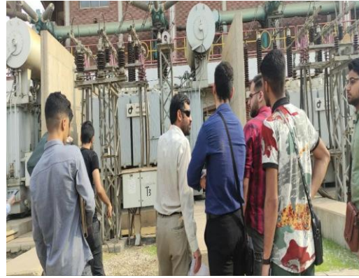
بازدید از پست برق GIS
