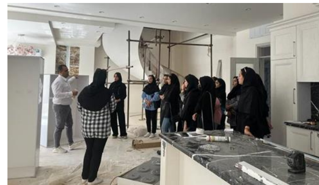
بازدید دانشجویان معماری از ساختمان نیمه تمام مسکونی
