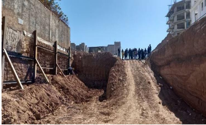
بازدید دانشجویان معماری دختران کرمان از گودبرداری ساختمان
